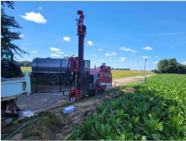
Foreuse SD F1 sur chantier
