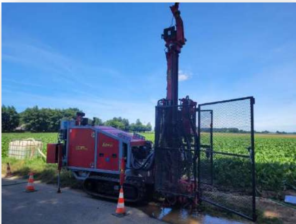
Foreuse SD F1 sur chantier
